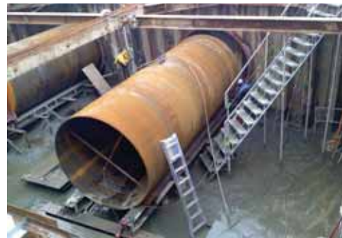
거제도 가스관 추진 시공
