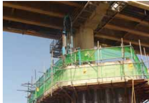
구미 낙동강 30공구 교각기초보강
