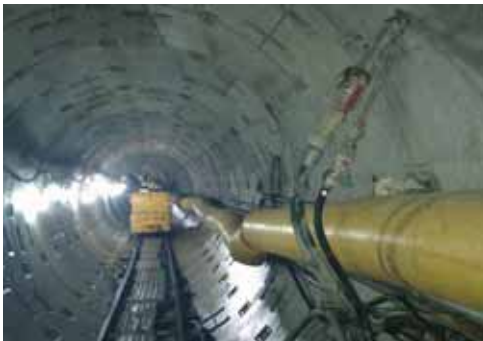
도봉의정부간 한전전력구세미실드 백필
